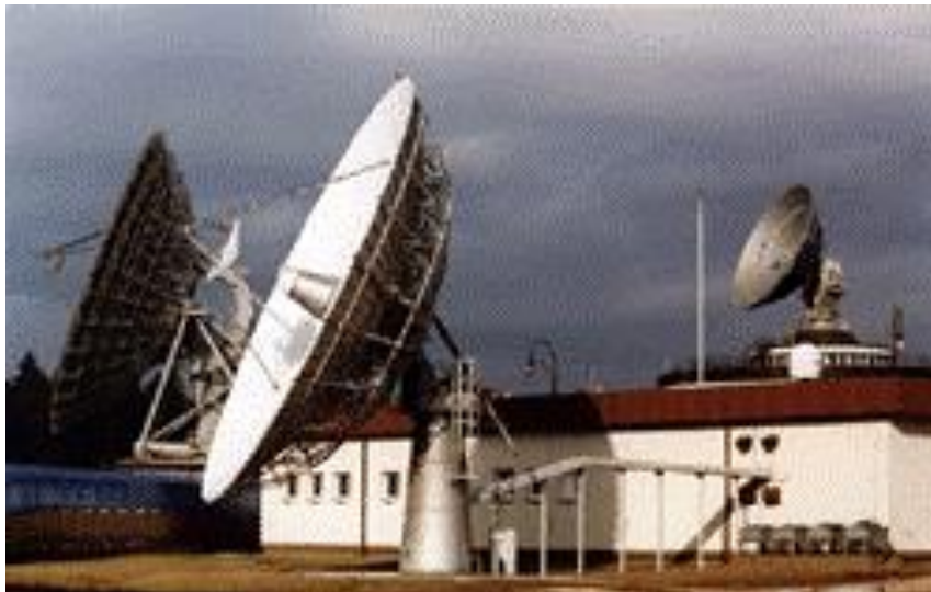
Rys.5.105. Stacja VSAT w Porębach Leśnych
